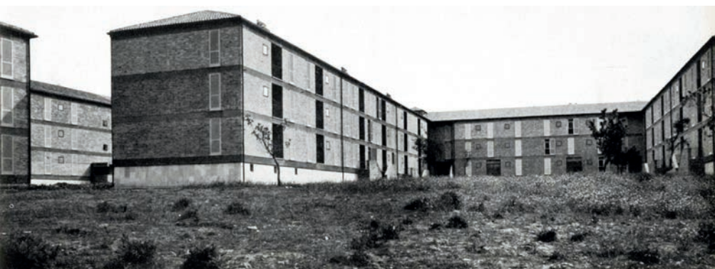
Fig.3 - Carlo Aymonino (capogruppo), Quartiere A Spine Bianche (1955-1959). Vista d'epoca dell'interno di una corte verde di vicinato tra i blocchi residenziali in linea (Casabella-Continuità, 231, 1959)
