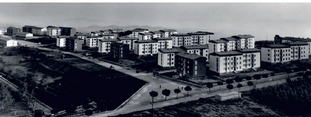
Fig.4 - Marcello Fabbri, Mario Coppa (capigruppo), Quartiere C Lanera (1955-1960). Veduta d'epoca dell'intervento appena realizzato (Archivio Centro Studi Tradizioni popolari in Puglia, Basilicata e Calabria)
