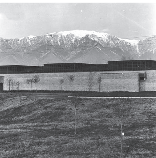
Fig.6 - Veduta della fabbrica Brionvega da Sud, con il monte Grappa sullo sfondo, 1968 (Balerna, Archivio del Moderno, fondo Marco Zanuso)
